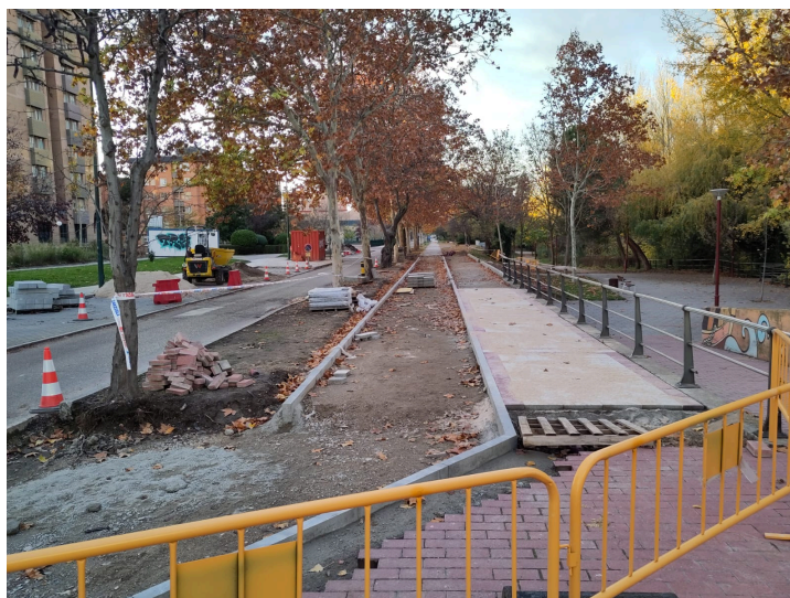
Acera-bici de nueva creación en la Calle Eras, Valladolid (España), ocupando espacio peatonal y verde, talando árboles, con anchos insuficientes y peligrosos y radios de giro mortales.
